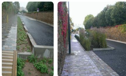
Exemple d'intégration de surfaces d'infiltration des eaux pluviales dans les espaces publics
