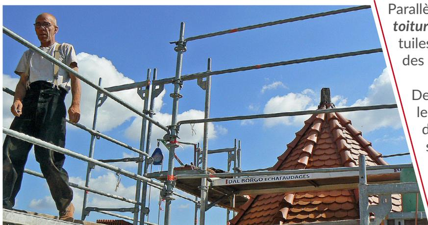
Parallèlement, la même entreprise est intervenue sur **les toitures des Halles** avec notamment le nettoyage des tuiles « canal » consistant en un grattage et l'enlèvement des mousses pour un coût HT de 14.531 €.
